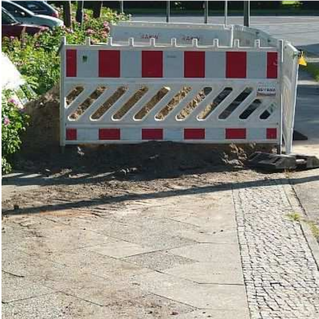
Foto 28: Gehweg mit regelkonformer Breite und einer handelsüblich breiten mobilen Absturzsicherung.
