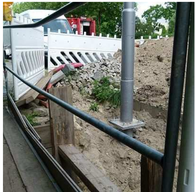
Foto 16: ... und die obere Strebe ist in Höhe 85 Zentimeter nicht regelkonform.
