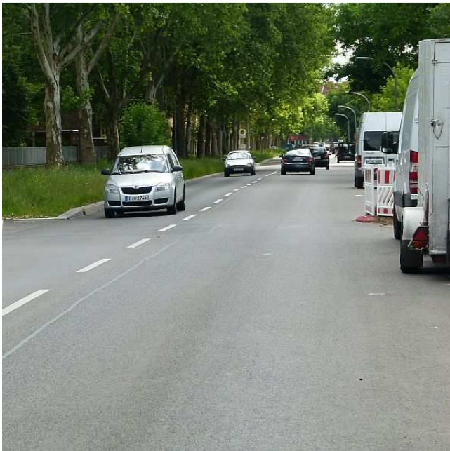
Foto 23: Verbleibende Fahrbahn mit einer Spurbreite von 3,80 Metern in einer Tempo 30-Straße ...
