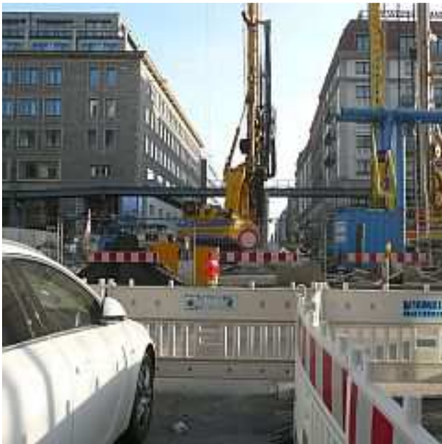
Foto 25: An dieser Einmündung mit einem sehr hohen Fußverkehrsaufkommen wurde der Überweg gesperrt...
