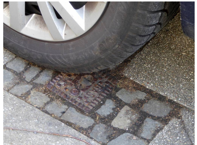
Bild 15: Im Gehweg liegen Zugänge zu Gas- und Wasserleitungen.
