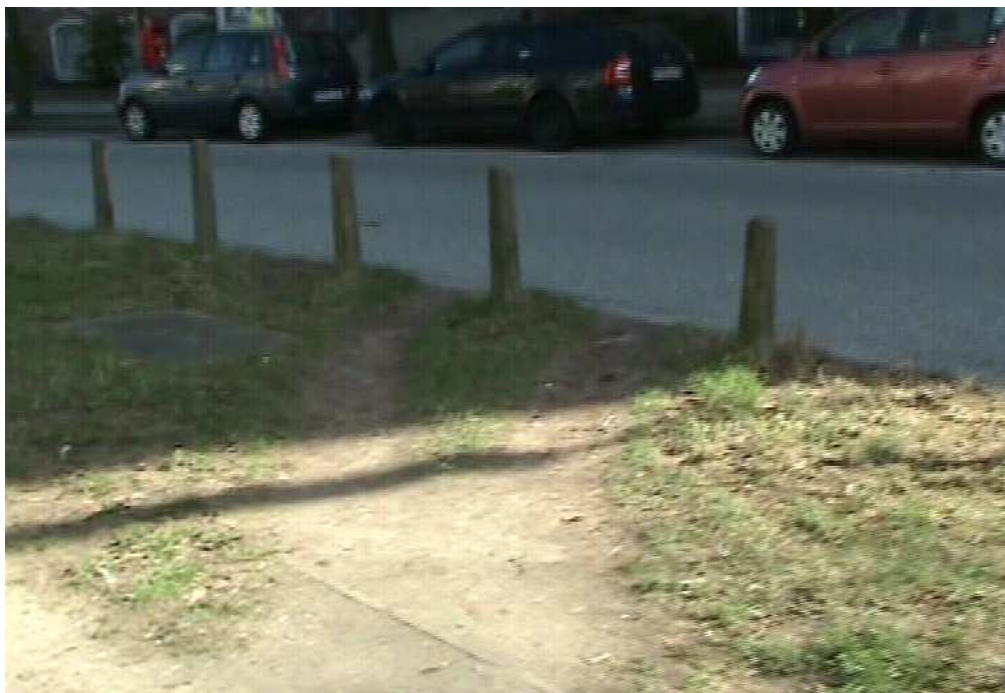
Abbildung 30: Trampelpfad im Einmündungsbereich Von-Essen-Straße / Hansdorfer Straße in Richtung Hansa-Kolleg
