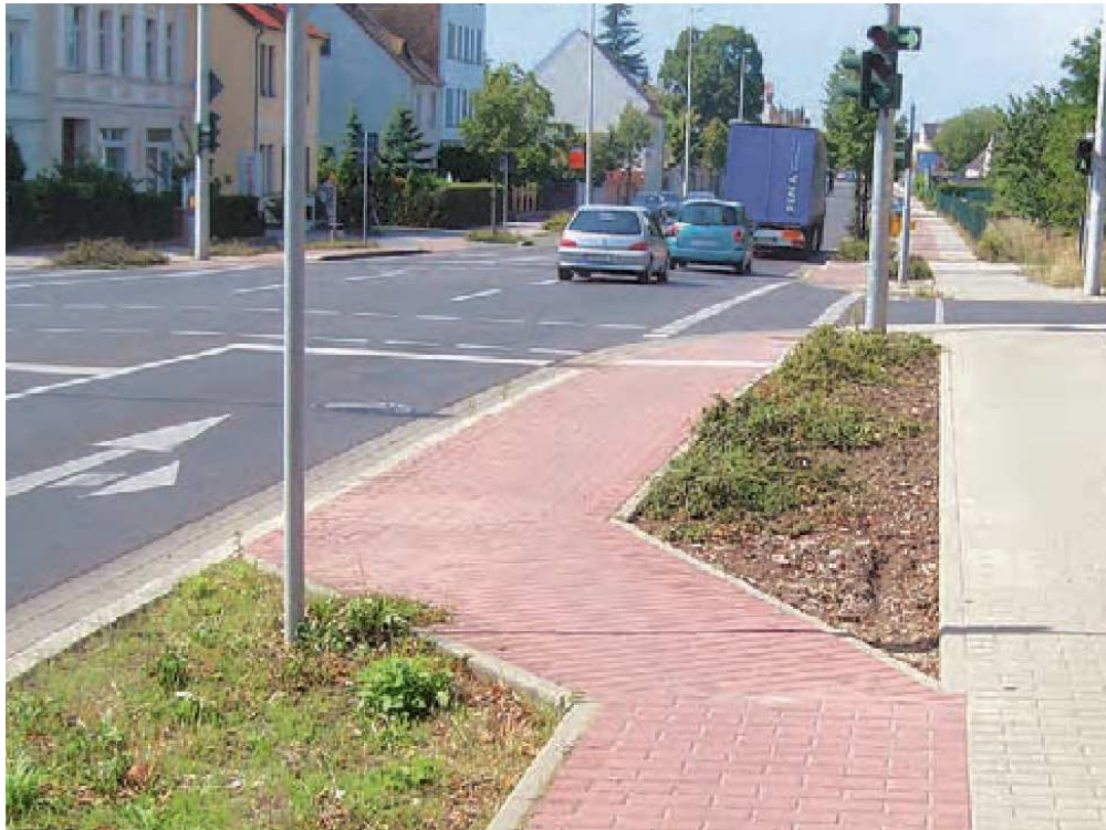
Abbildung 70: Beispiel fahrbahnahe Anlage von Radwegen [10]
