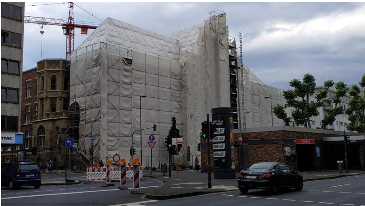
Baustellensituation am alten Hansa-Gymnasium Gebäude. Hansaring mit Haltestelle Hansaring, wo viele Schüler:innen ankommen.
