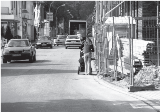
Abbildung 9 „Fußgänger bitte Gehweg gegenüber benutzen“ - Wo dieses Baustellenschild steht, muss auch für eine sichere Straßenquerung gesorgt werden.
