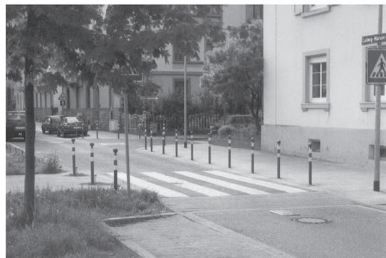
**Abbildung 5 + 6** Zebrastreifen mit Plateau- oder Teilpflasterungen wirken geschwindigkeitsreduzierend
